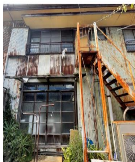
江戸川乱歩館エントランス棟 改修前 中庭側
