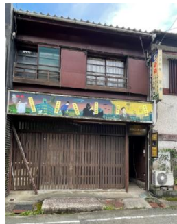
江戸川乱歩館エントランス棟 改修前 本町側
