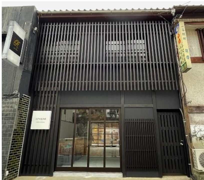
江戸川乱歩館エントランス棟 改修後 本町側
