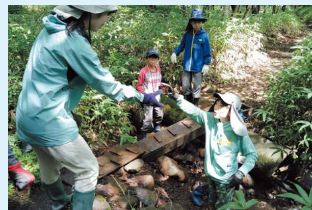
清里の森の中で自然歩道の修復中
