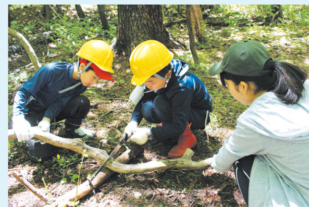
清里の森の中で自然歩道の修復中
