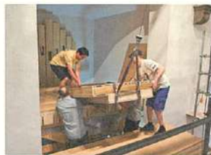
オルガン室組立作業
