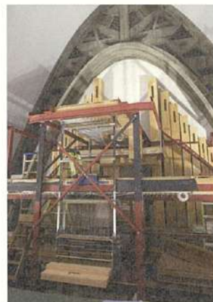
オルガン内部の鉄骨
