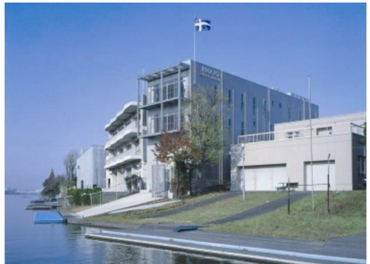
改修工事を行ったボート部合宿所(埼玉県戸田市)
