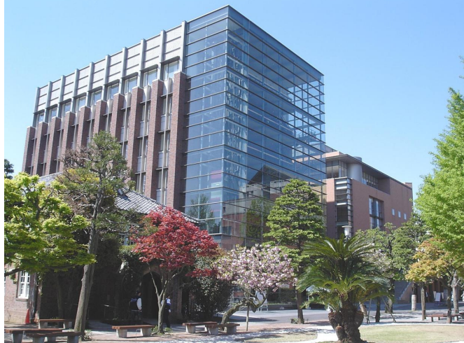
新築の11号館(主に法務研究科、独立研究科で利用)
