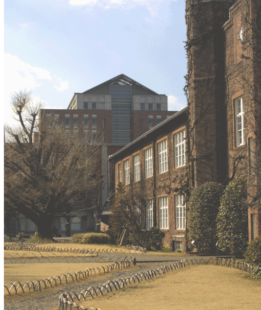
本館(右)および12号館(社会科学系研究棟)
