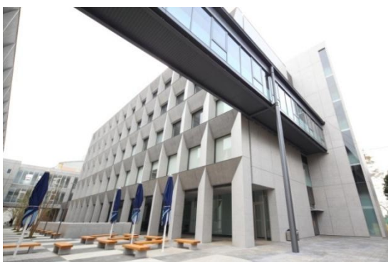
4号館増築部分
