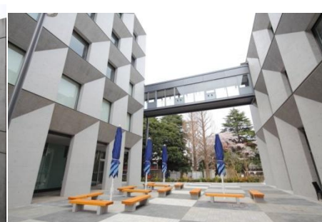
左8号館、右4号館増築棟
