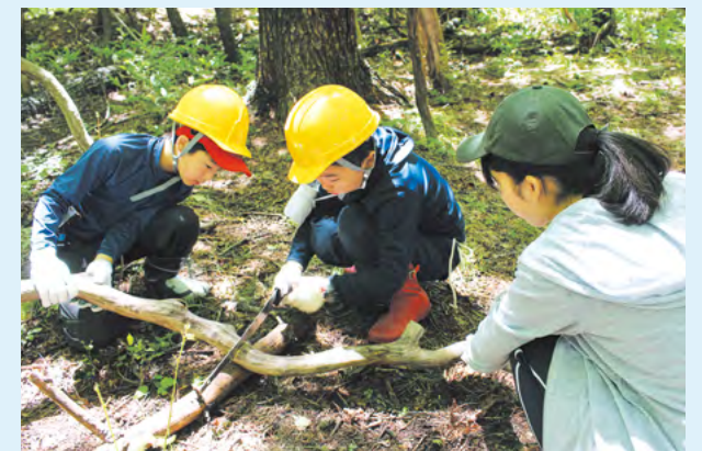
清里の森の中で自然歩道の修復中
